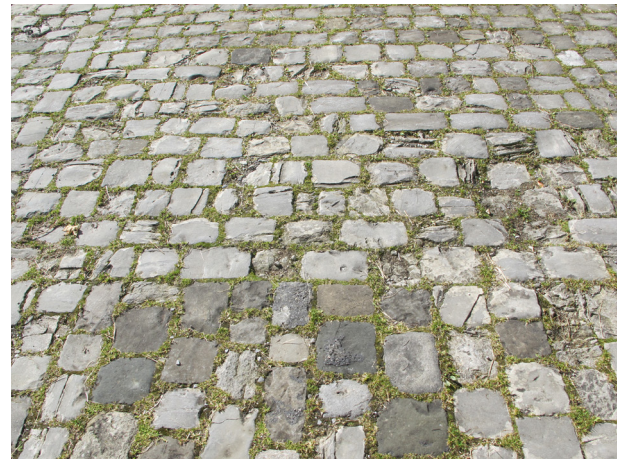
Abb. 28 Sandsteinpflasterung nach historischem Vorbild
