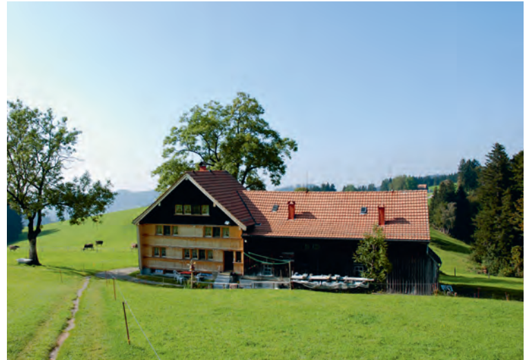
Südfassade nach der Sanierung, neue Vertäferung im Erd- und Obergeschoss
