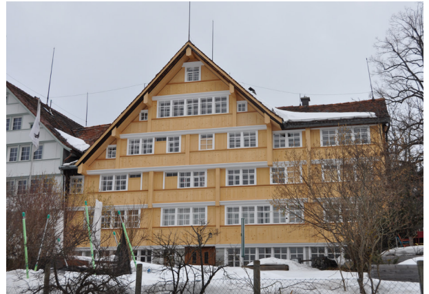
Abb. 31 Energetisch saniertes bäuerliches Fabrikantenhaus, Dorf 8, Speicher
