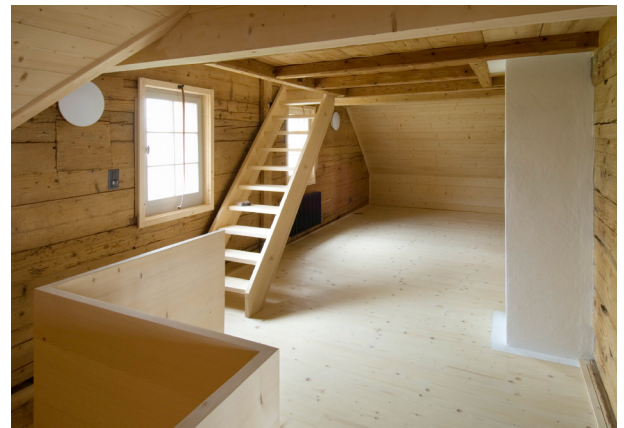
Abb. 41 Innenverkleidung mit Dachdämmung, Wannen 241, Wald
