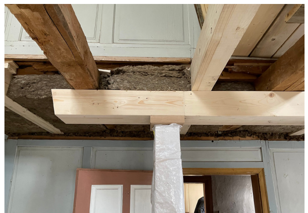
Abb. 11 Dämmung zwischen Geschossdecke, Dorf 31, Schwellbrunn
