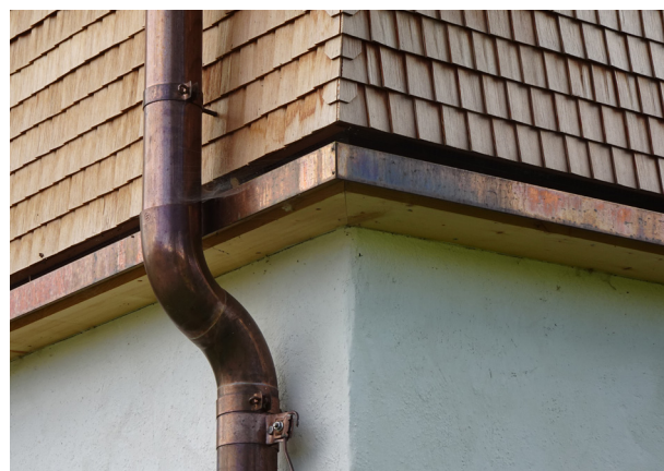
Abb. 34 Detail energetisch sanierte Schindelfassade, Hinterhof 2240, Herisau
