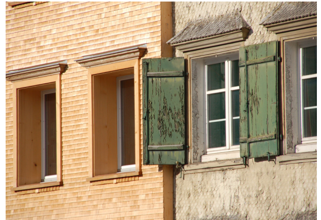
Abb. 4 Gedämmter Schindelschirm und ursprünglichem Schindelschirm, Speicherstrasse, Trogen
