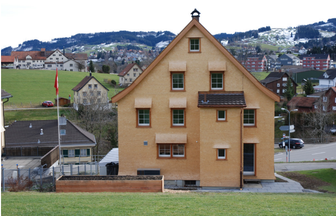
Abb. 38 Energetisch saniertes Gebäude freistehend, Kohlhal- den 11, Speicher Bildarchiv Denkmalpflege Appenzell Ausserrhoden
