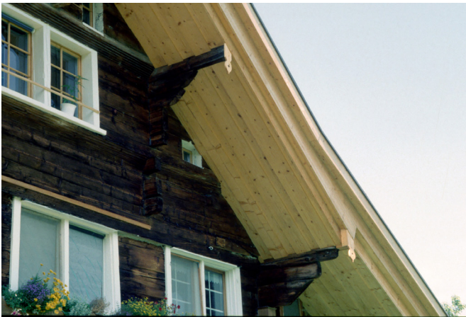
Abb. 37 Steildach mit Überstand, Hinterhasli 314, Wolfhalden Bildarchiv Denkmalpflege Appenzell Ausserrhoden
