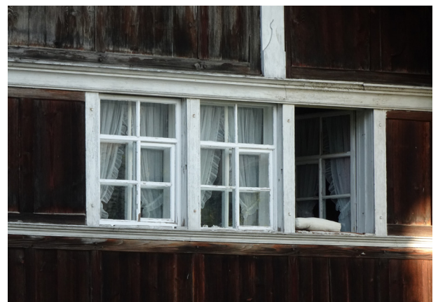
Abb. 29 Hauptfassade mit Fensterflügel, Hechtgasse 10, Wolfhalden
