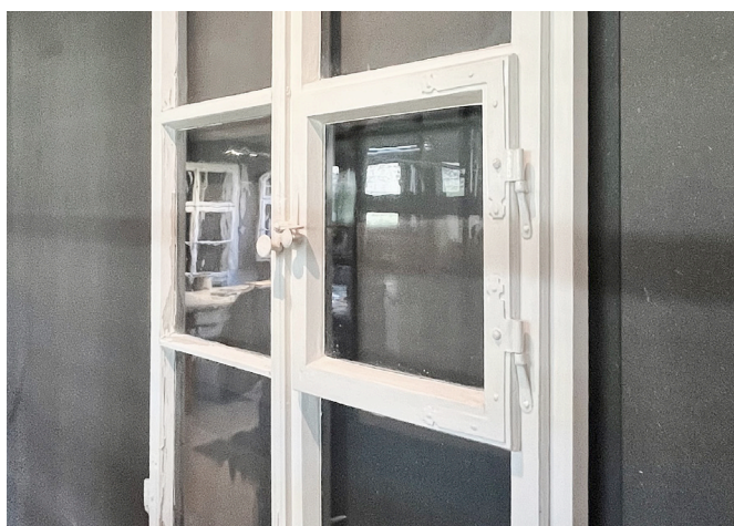
Abb. 39 Winkelbänder, Riegel
