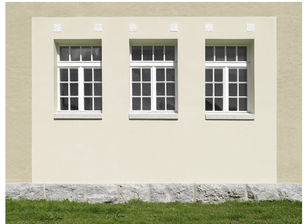
Abb. 33 Doppelverglasung von 1908, Detail, Krombach 8, Herisau
