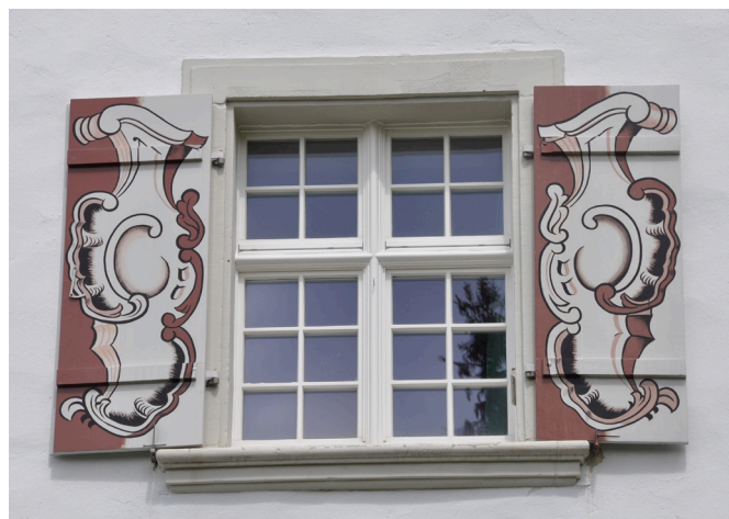
Abb. 73 8-er Teilung mit Mittelpfosten und Kämpfer, Doppelpalast, Nideren 2, Trogen
