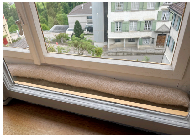
Abb. 54 «Zugdackel» zwischen Fenster und Vorfenster
