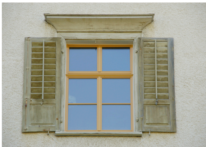
Abb. 74 Doppelflügel mit Kämpfer, Göpsistrasse 709, Teufen
