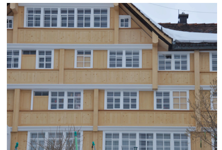
Abb. 61 «Historisches oder «Restover» Glas von aussen, Dorf 8, Speicher
