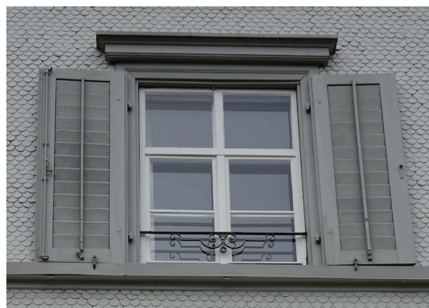
Abb. 45 Absturzsicherung verziert, Hechtstrasse 14, Teufen
