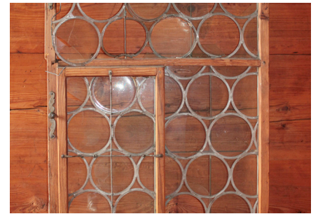
Abb. 58 Butzenglasfenster mit Windstangen
