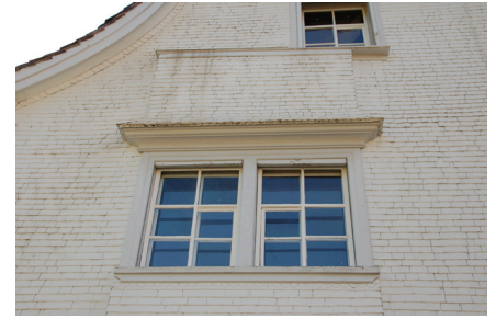
Abb. 22 Vorfenster innen hinter Fallladen, Dorfplatz 12, Gais
