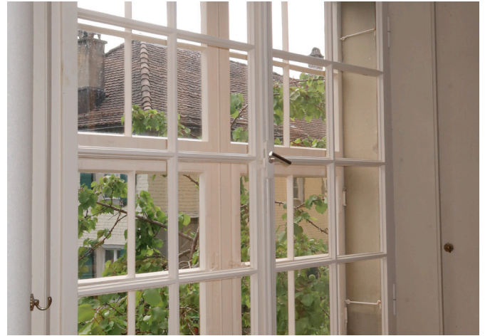
Abb. 42 Stangenverschluss
