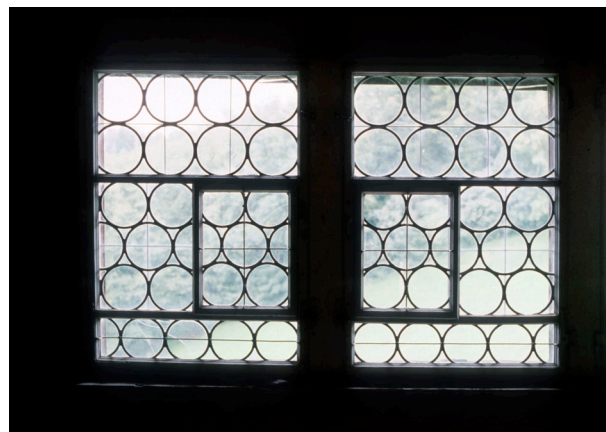
Abb. 69 Butzenfenster mit 3-er Teilung und Schieber, Almendsberg 585, Walzenhausen
