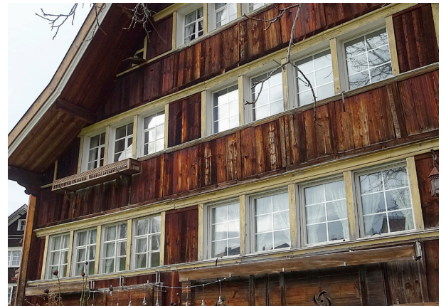
Abb. 77 Fenster mit Sprossen zwischen dem Glas, Dorf 38, Grub
