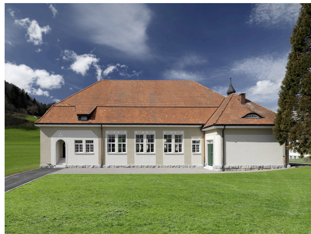
Abb. 32 Doppelverglasungen von 1908, S0-Fassade, Krombach 8, Herisau
