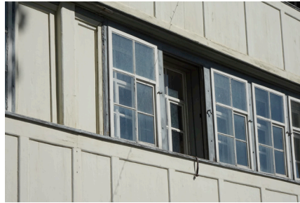
Abb. 24 Vorfenster aussen vor Zugladen mit Vorreiber, Dorfstrasse 94, Bühler
