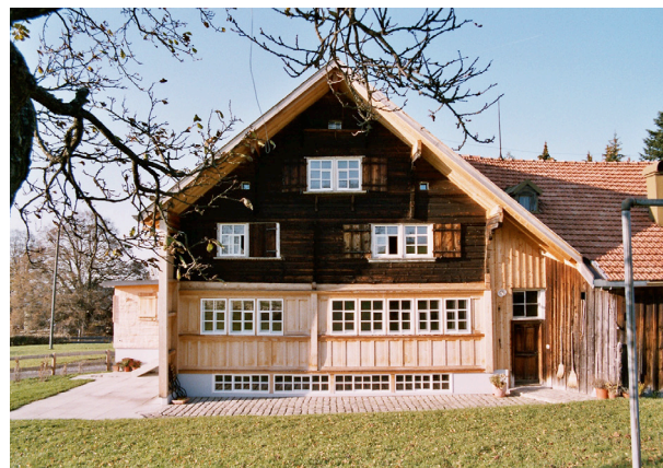
Abb. 5 Schloß-Fenster unter First- und Mittelpfetten, Spiessenrüti 514, Teufen
