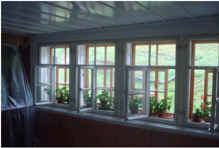
Abb. 23 Vorfenster aussen vor Laden mit Öse und Riegel
