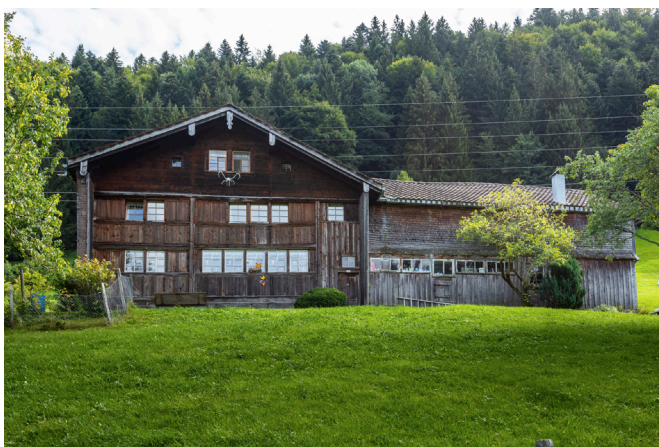
Abb. 3 Tätschdachhaus mit Stallanbau, Hinterfür 980, Urnäsch
