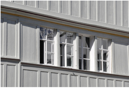
Abb. 20 Vorfenster innen hinter Zugladen, Gossauerstrasse 1, Herisau
