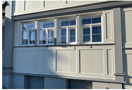
Abb. 21 Vorfenster innen hinter Zugladen, Niederstein 113, Stein
