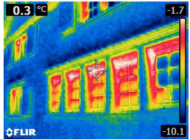
Abb. 10 thermografische Aufnahme Wohnhaus
