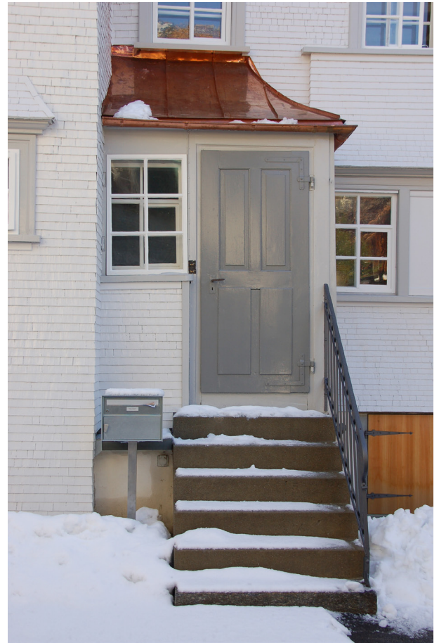
Abb. 16 Brusttäfer, Landsgemeindeplatz 4, Trogen
