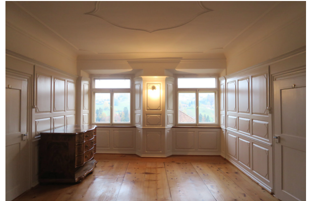
Abb. 14 Brusttäfer, Landsgemeindeplatz 4, Trogen
