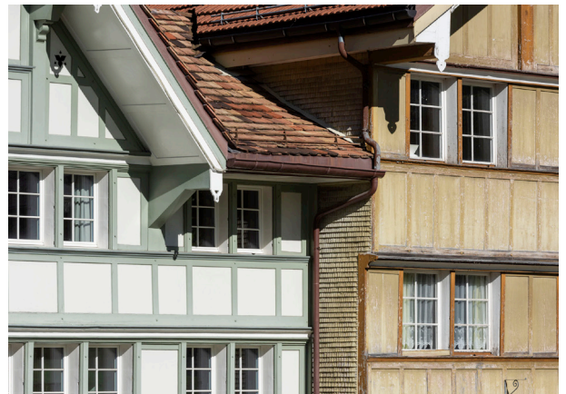
Abb. 47 Täferfassade gestrichen, Friese und Füllungen mit Kontrast, Dorf 13,14, Hundwil
