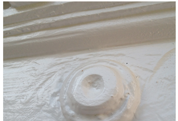
Abb. 24 Holzfassade mit Schleifspuren
