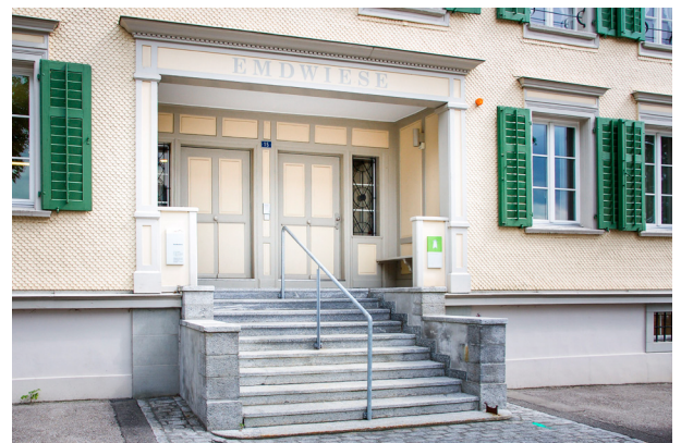
Abb. 9 Eingangsanlage Schulhaus, Poststrasse 15, Herisau
