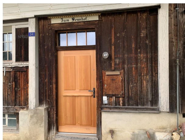
Abb. 4 Türe mit Oblicht, Huebstrasse 34, Herisau Bildarchiv Denkmalpflege Appenzell Ausserrhoden
