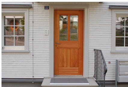
Abb. 23 Haustüre mit Glaseinsatz, Hauptstrasse 18, Teufen
