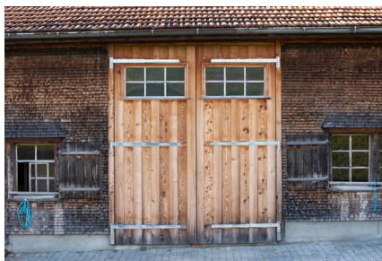
Abb. 24 Tenntor neu mit Deckelschalung und Glaseinsatz, Nord 5, Rehetobel
