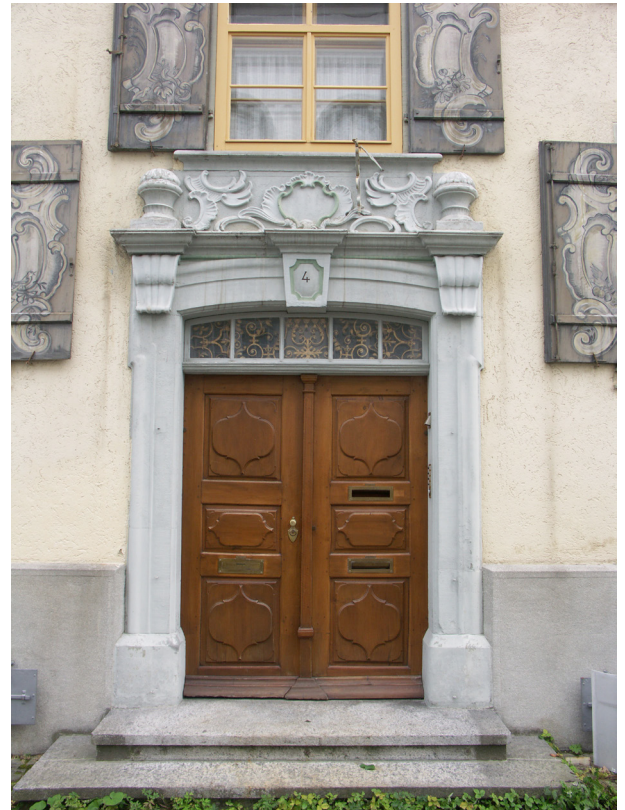
Abb. 8 Fabrikantenhaus mit Doppeltüre und verziertem Gewände, Landsgemeindeplatz 4, Trogen
