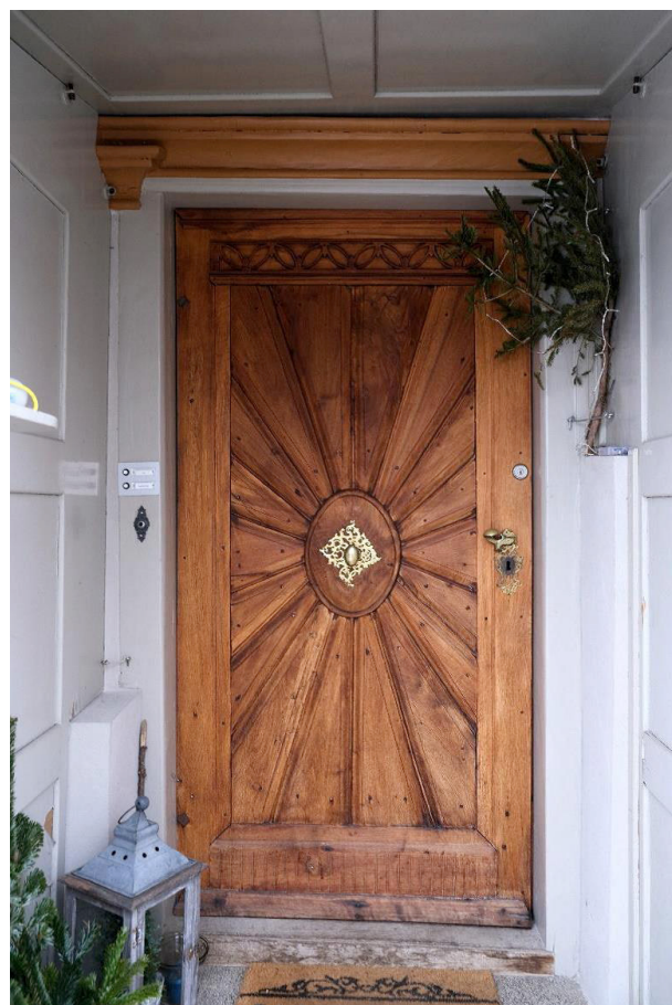
Abb. 3 Türe radial genutet, Schwantleren 23, Gais Bildarchiv Denkmalpflege Appenzell Ausserrhoden
