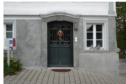
Abb. 26 Haustüre mit Glaseinsatz und Gitter, Dorf 26, Speicher
