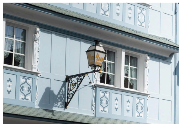
Abb. 62 Klebdächlein mit Hohlkehle vergipst, Hauptgasse 22, Appenzell
