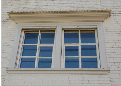
Abb. 57 Sturz mit Hohlkehle und Viertelstab, Dorfplatz 12, Gais
