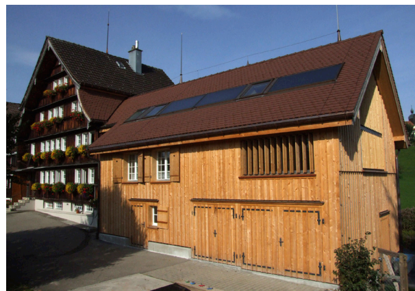
Abb. 3 Stall mit Leistenschirm, Huebstrasse 16, Herisau
