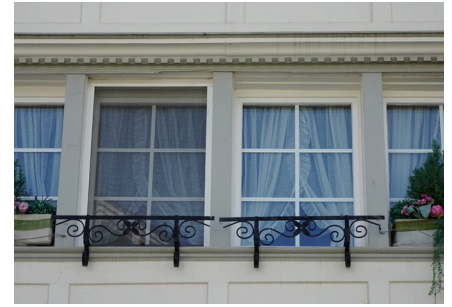
Abb. 58 Sturz mit Hohlkehle und Würfelstab, Dorf 29, Hundwil
