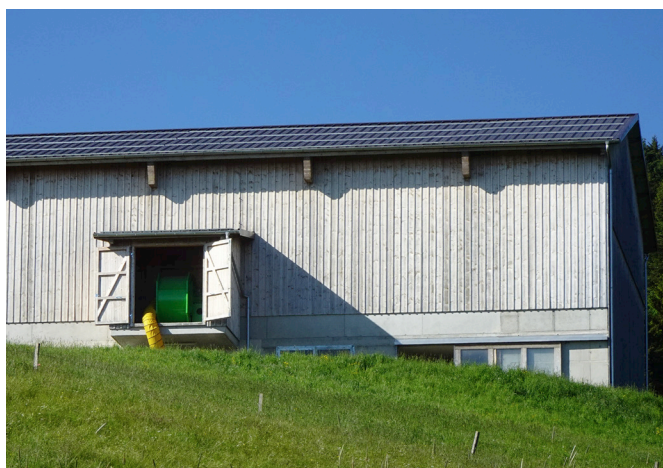
Abb. 29 Deckelschalung mit unterschiedlichen Brettbreiten, Schwarzenegg 611, Grub
