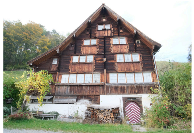
Abb. 49 Steckbretter Obergeschosse, Schwendi 1, Heiden
