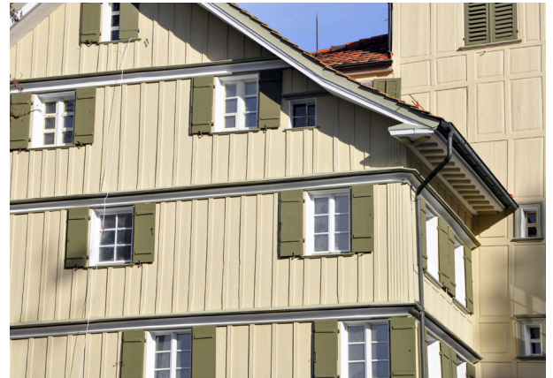
Abb. 23 Leistenschirm mit Sturzsimse pro Geschoss, Poststrasse 4, Herisau
