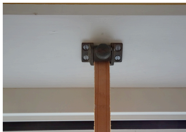
Abb. 70 Ladenklemme Eisenguss mit gerilltem Exzenter
