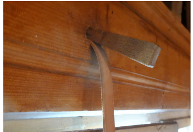
Abb. 68 Klemmkeil für Ladenriemen aus Hartholz
