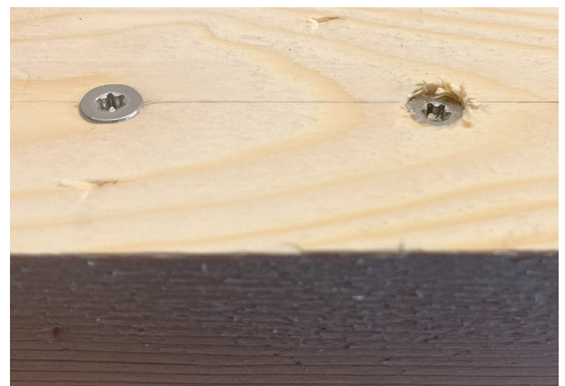
Abb. 40 Schraube richtig und zu tief eingedreht
