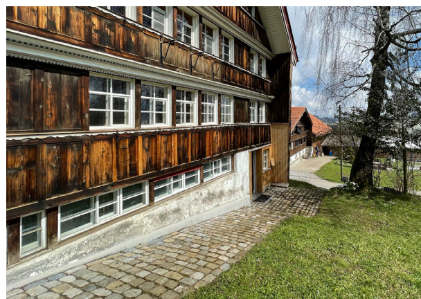
Abb. 10 Täferfassade mit profilierten horizontalen Bauteilen, Hinterhof 2240, Herisau
