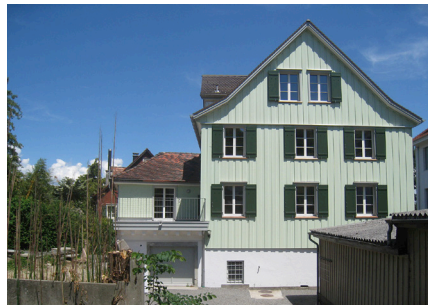
Abb. 18 Deckelschalung neu, Tobelmühle 357, Wolfhalden
