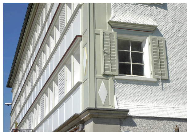
Abb. 11 Täferfassade mit Sturz- und Brüstungssimsen, Dorfstrasse 98, Bühler
