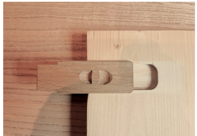
Abb. 66 Schubriegel Eichenholz
