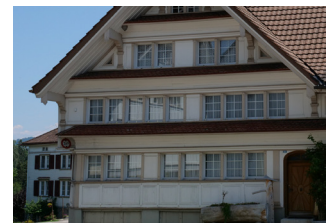
Abb. 87 Füllung abgeplattet, mit geschweift mit Falz, Dorf 30, Hundwil
