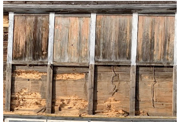
Abb. 72 Strickwand, Wasserspuren, Insektenbefall, Hanfseile, Hugenwees, Gonten
