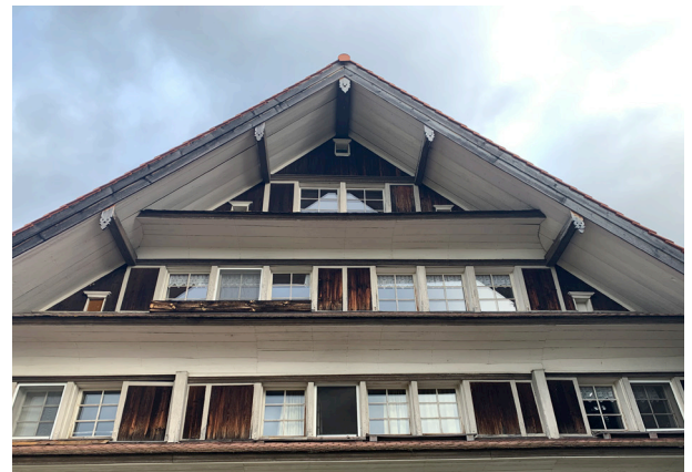
Abb. 61 Klebdächer mit Hohlkehlen gestrichen, Huebstrasse 34, Herisau
