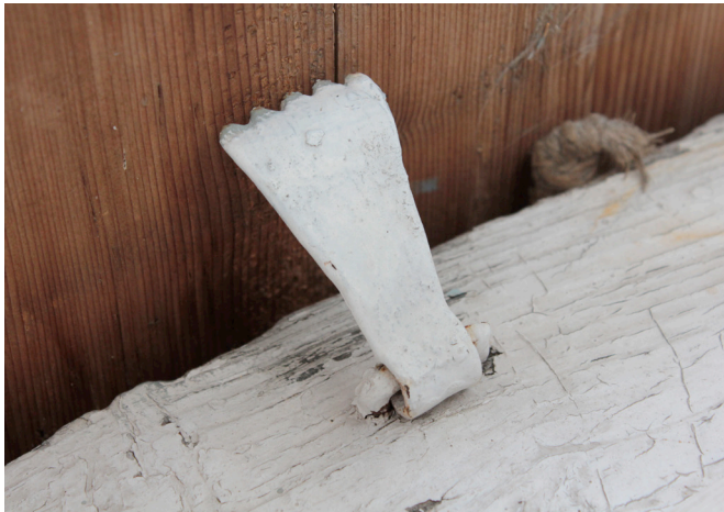
Abb. 63 Kalle als Ladenarretierung
