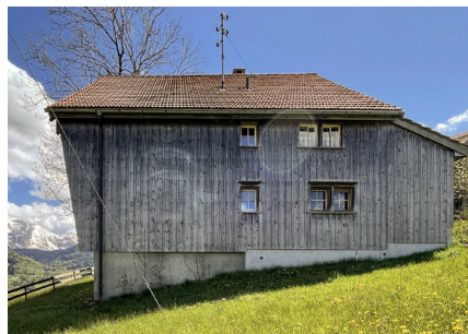
Abb. 19 Leistenschirm, Untere Egg 521, Urnäsch
