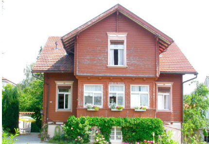
Abb. 17 Chaletschalung, Haus «Rütli», Badstrasse 4, Heiden
