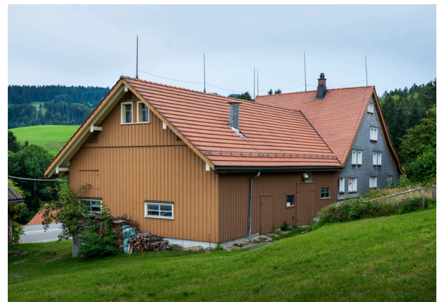
Abb. 22 Giebelfassade mit überschobenem Leistenschirm, Schachen 4, Reute
