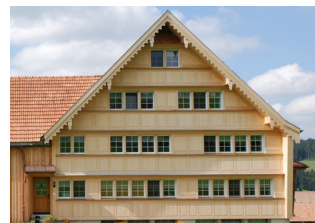
Abb. 85 Füllung abgeplattet, schräg mit Falz, Schächenen 111, Hundwil
