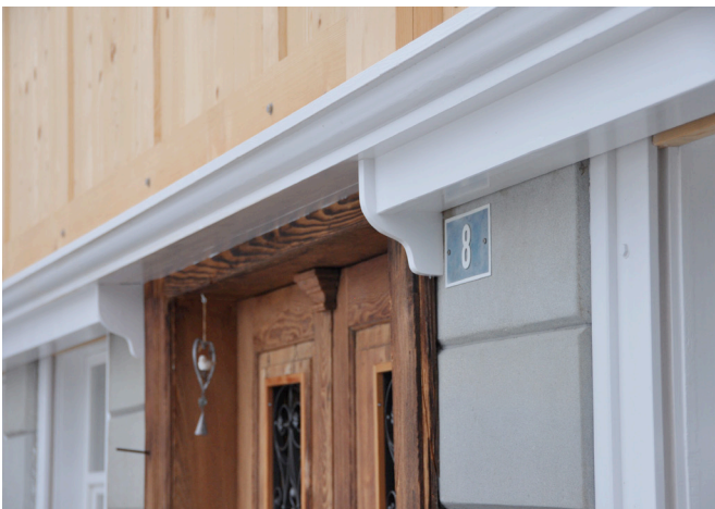
Abb. 12 Rechteckprofile und Viertelstab, Dorf 8, Speicher
