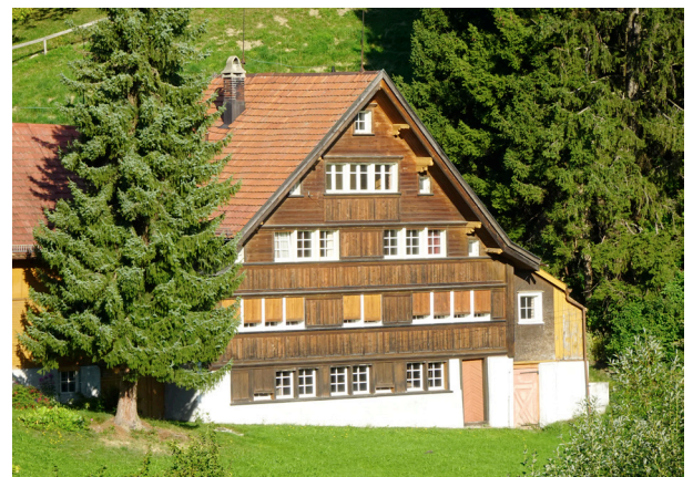
Abb. 74 Fenster in Giebelfassade mit Fallläden, Vogelherd 68, Wolfhalden
