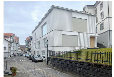
Abb. 20 Kirchgemeindehaus, Schmiedgasse, Herisau
