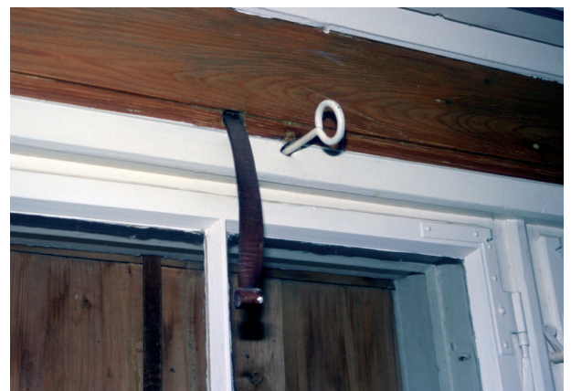
Abb. 69 Ladenarretierung mit Ringdorn
