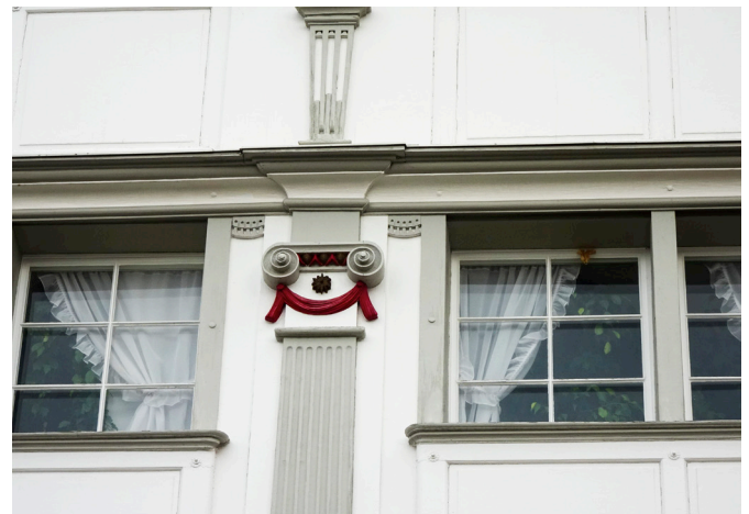
Abb. 14 Pilaster, Hohlkehle und Viertelstab, Dorfplatz 11, Gais
