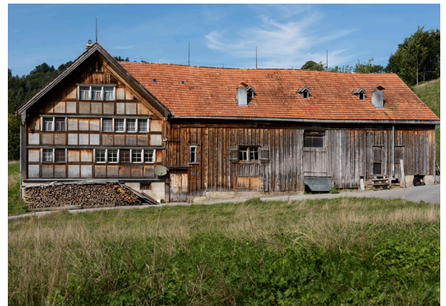
Abb. 50 Täferfassade gestemmt, Unterschlatt 1, Haslen
