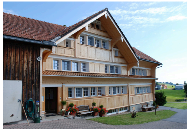
Abb. 60 Klebdach mit Hohlkehle roh, Brisig 213, Schwellbrunn
