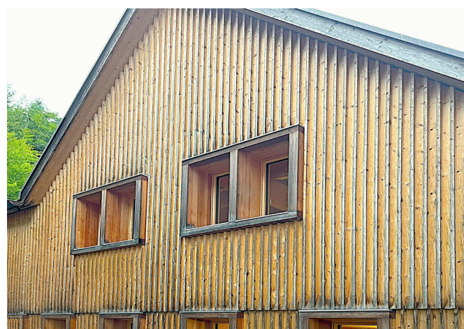
Abb. 33 Atelierhaus mit quadratischen Leisten, Tobel 132, Wolfhalden
