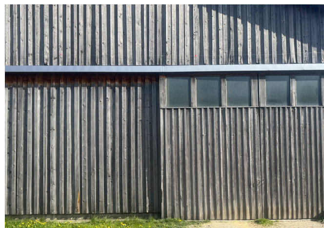
Abb. 32 Deckelschalung Fassade und Leistenschirm Schiebetor, Schwarzenegg 119, Grub
