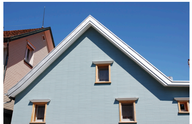
Abb. 28 vollständig eingepacktes Ortbrett, Wienacht 7, Lutzenberg, (unpassend) Bildarchiv Denkmalpflege Appenzell Ausserrhoden
