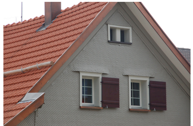
Abb. 27 Ortrinne und Ortbrett 12 cm mit Blechverkleidung, Hinterdorf 6, Trogen Bildarchiv Denkmalpflege Appenzell Ausserrhoden
