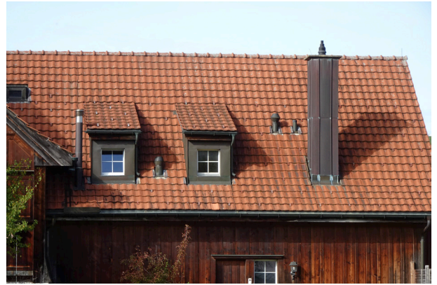
Abb. 23 Kamin mit Blechverkleidung, Zwislenstrasse 40, Gais (unpassend)
