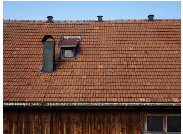
Abb. 26 Stallentlüftung mit Tonnendächlein, Möser, Gais Bildarchiv Denkmalpflege Appenzell Ausserrhoden
