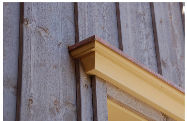
Abb. 15 Fensterdächlein mit Blech abgekantet, Oberdorfstrasse 42, Herisau
