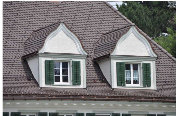
Abb. 18 Gaube mit Schindelschirm, Cilanderstrasse 16, Herisau
