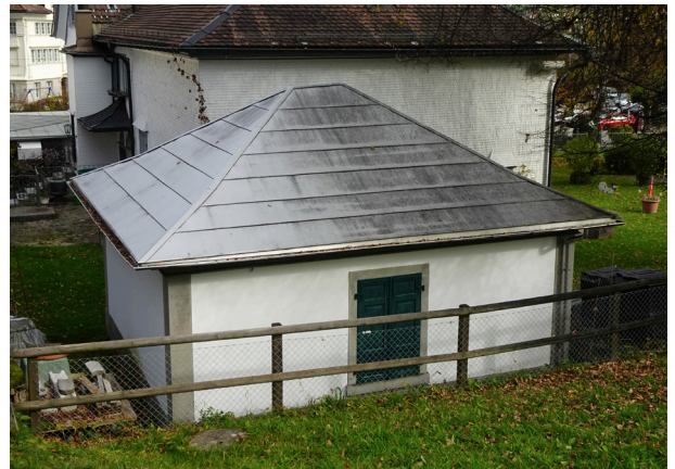
Abb. 10 liegender Falz, Hauptstrasse 25, Speicher
