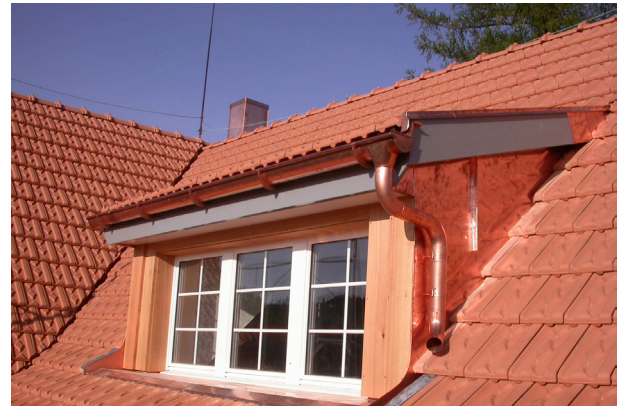
Abb. 13 Anschluss mit Hinterlüftung, Berg 18, Trogen
