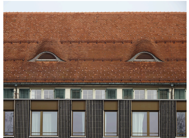
Abb. 32 Ziegeldach mit Gittern und Metallstoppern, Schützenstrasse 1, Herisau
