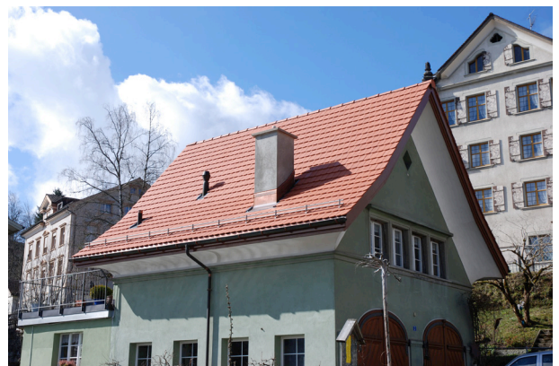
Abb. 12 Traufblech und Rinne mit Gefälle, Wäldlerstrasse 2, Trogen
