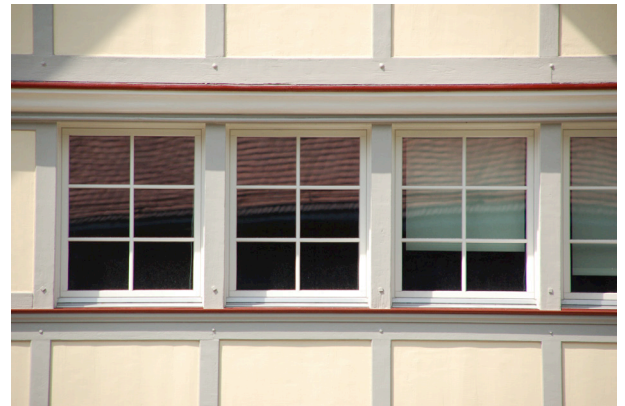
Abb. 14 Sims mit Wulst, Rosenegg 5, Hundwil
