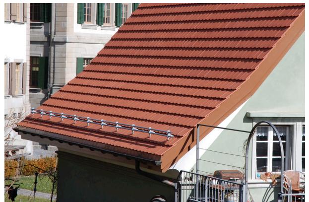
Abb. 31 Schneefang mit Rohren, Wäldlerstrasse 2, Trogen
