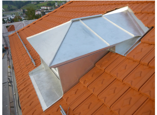
Abb. 19 Gaube mit Brustblech und durchgehender Ziegelreihe, Kirchplatz 6, Heiden
