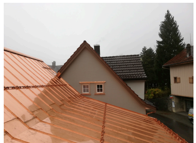
Abb. 9 stehender Falz, Egg 81, Schwellbrun
