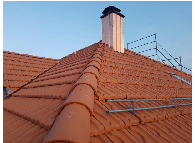
Abb. 24 Kamin mit Blechverkleidung gefälzt und Dächlein, Holderenstrasse 9, Rehetobel
