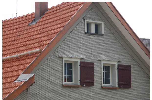
Abb. 11 Ortrinne mit Abkantung über Ort Brett-Oberkante, Hinterdorf 6, Trogen
