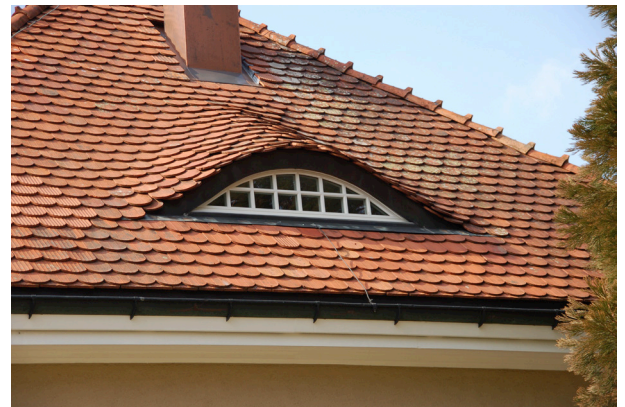
Abb. 21 Ochsenauge mit Ziegeleindeckung, Krombach 8, Herisau
