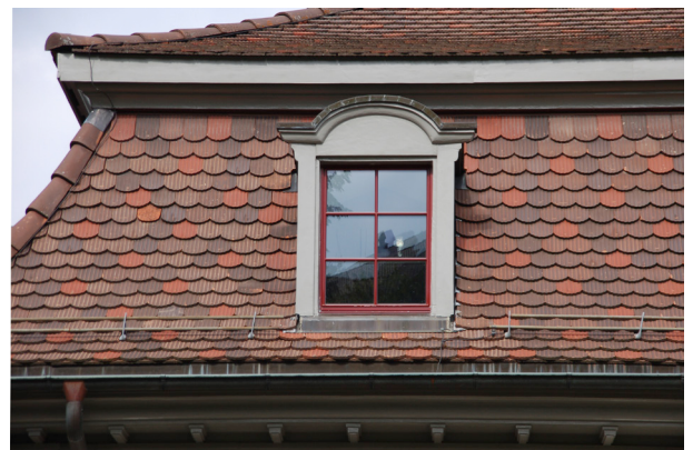
Abb. 44 Neueindeckung mit gemischten Ziegeln, Hinterdorf 1, Trogen
