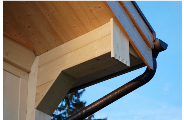
Abb. 13 Pfettenbrettchen mit Hohlmesserschnitt, Spies-senrüti 498, Teufen
