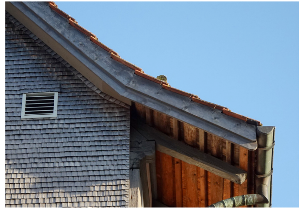
Abb. 24 Sturmklammer, Bergstrasse 19, Herisau
