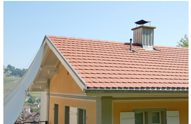
Abb. 33 Biberschwanzziegel mit Falz, Dorfhalde 139, Lutzenberg
