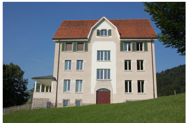
Abb. 43 Dach mit alten und neuen Ziegeln, Krombach 5, Herisau
