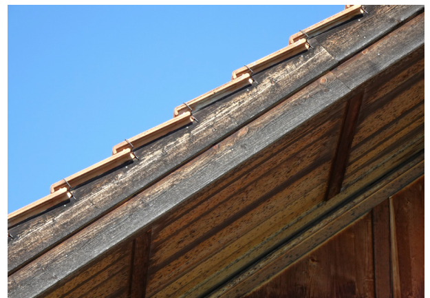
Abb. 14 Ortbrett 2-teilig überschoben, Saumhalde 13, Herisau
