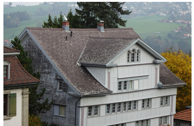
Abb. 49 Schieferplatten mit Haken, Hinterdorf 2, Trogen
