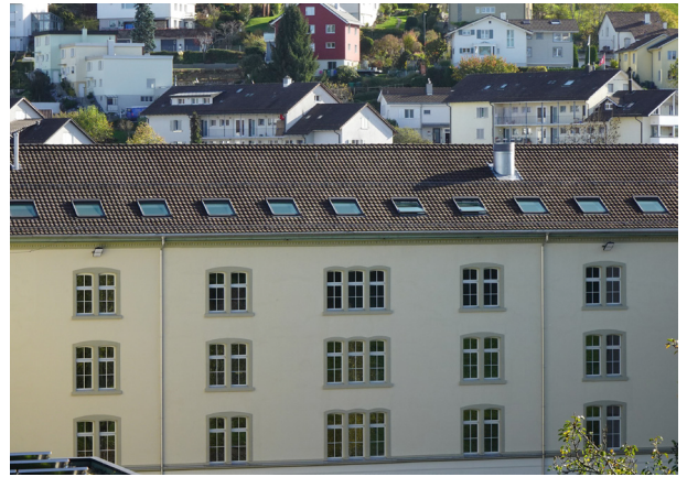
Abb. 21 Dachflächenfenster, Kasernensrasse 45, Herisau
