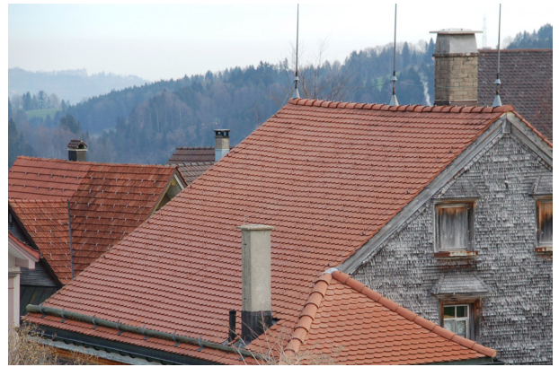
Abb. 32 Doppeldeckung, Krombach 5, Herisau
