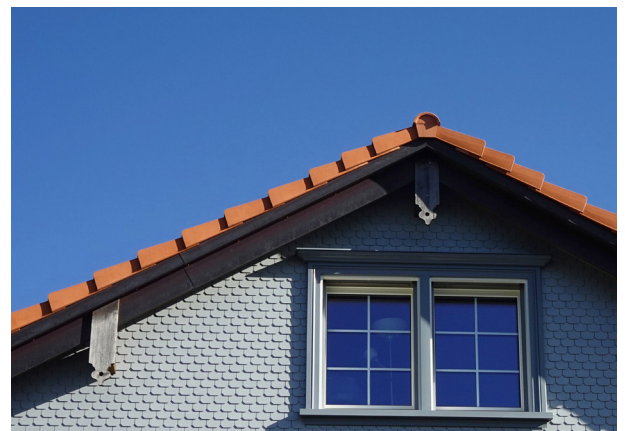
Abb. 26 Ortgangziegel neu, Rechberg 2288, Herisau (unpassend)
