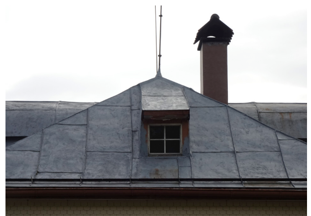
Abb. 50 Blechdach mit Stehfälzen, Hauptstrasse 87, Teufen
