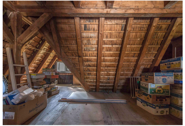
Abb. 7 Dachlatten, Kreuzstrasse 17, Herisau
