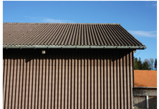
Abb. 48 Wellplatten geschraubt, Rohren 2295, Herisau
