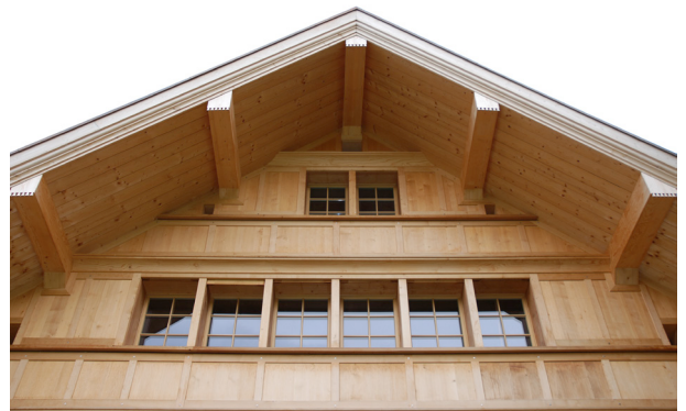
Abb. 16 Untersicht längs verschalt, Robach 363, Rehetobel
