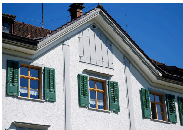
Abb. 7 Klappladen für Lastenaufzug, Göbsistrasse 709, Teufen
