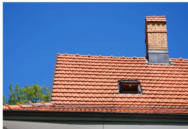
Abb. 30 Dachflächenfenster, Poststrasse 26, Heiden Bildarchiv Denkmalpflege Appenzell Ausserrhoden
