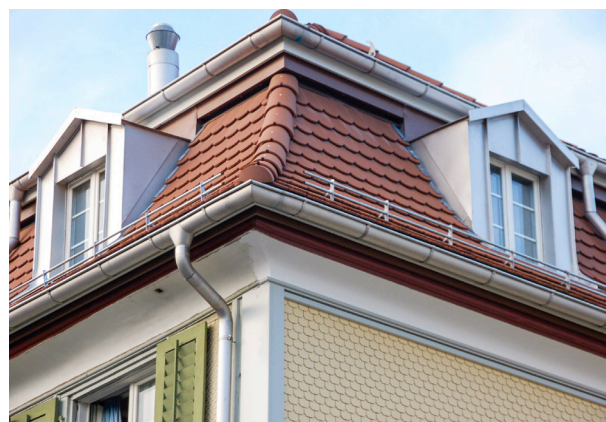
Abb. 34 Giebelgaube mit Blechverkleidung, Gossauerstrasse 51, Herisau
