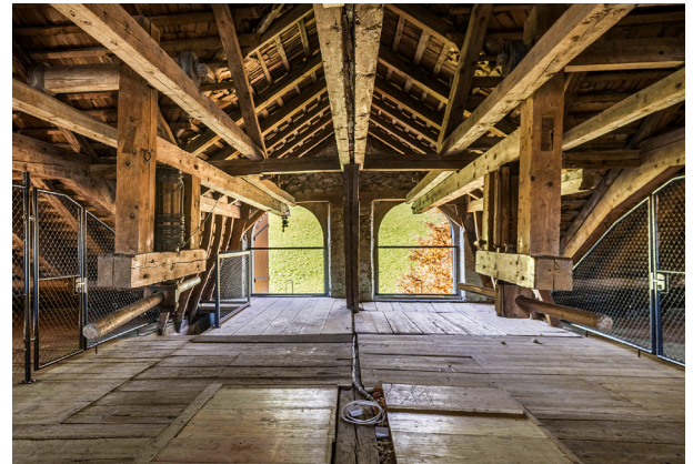
Abb. 19 Dachstuhl Fabrikantenhaus, Landsgemeindeplatz 11, Trogen
