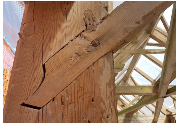
Abb. 42 Holzverbindung Kubelbrücke, Herisau/Stein
