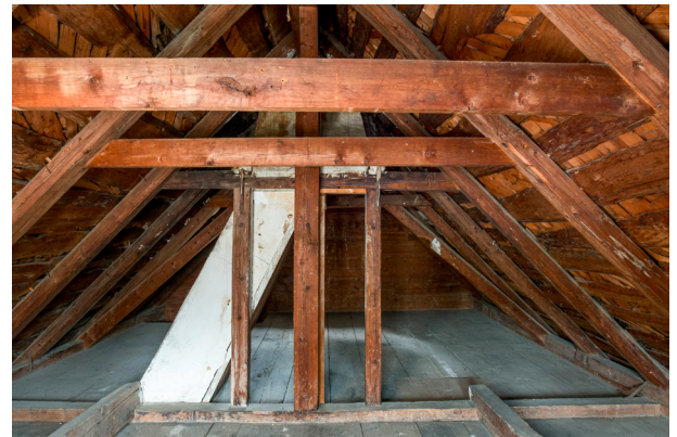
Abb. 12 Kehlbalken als Verstärkung der Sparrenpaare
