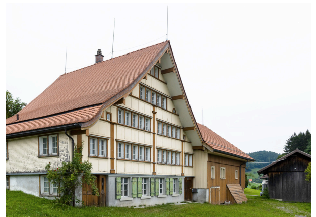
Abb. 39 Vordach mit auskragenden Pfetten, Schachen 4, Reute
