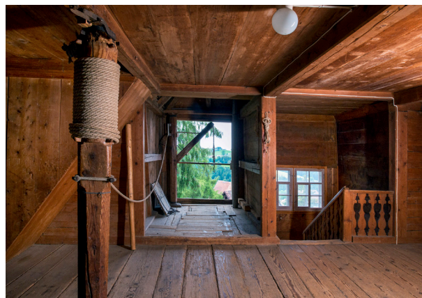
Abb. 6 Ladenöffnung mit Kranarm und Warenaufzug, Hinterdorf 9, Trogen
