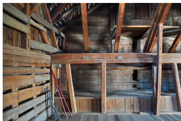
Abb. 14 Dachstuhl eh. Remise, Buchenstrasse 5, Herisau Bildarchiv Denkmalpflege Appenzell Ausserrhoden
