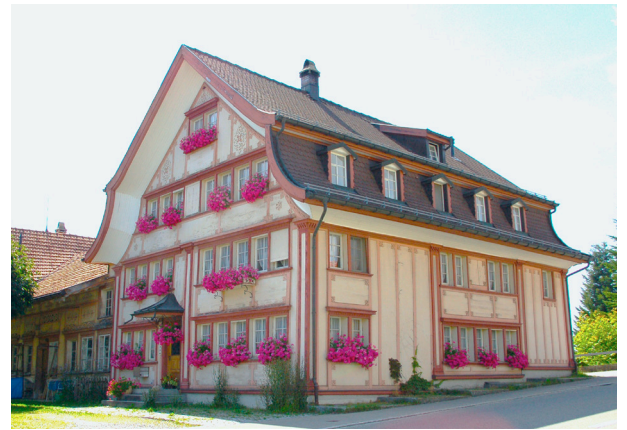
Abb. 38 Mansardengeschoss, Unterdorf 10, Wald
