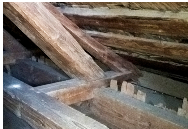
Abb. 20 Stichbalken, Wechsel und Aufschiebling
