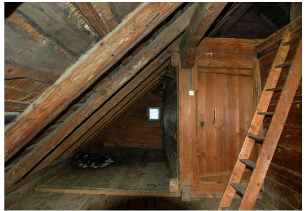
Abb. 4 Firstkammer und Schluff, Badgüetli 2, Waldstatt
