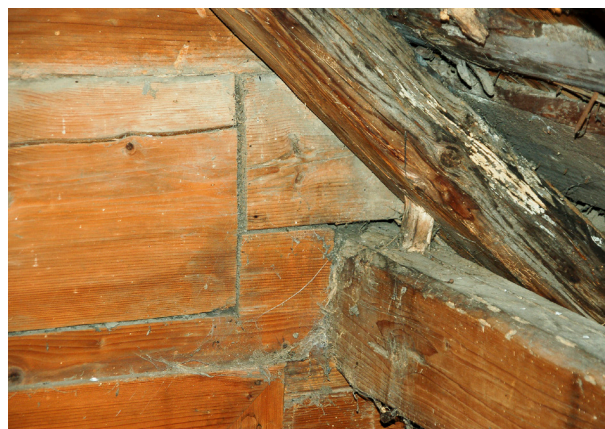
Abb. 8 Rafen/Sparren auf Pfette mit Holzdübel
