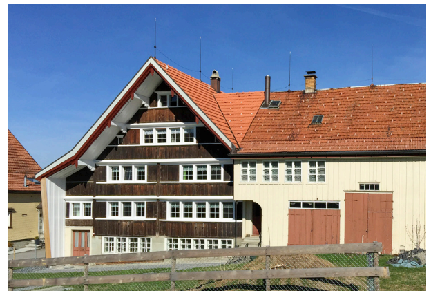
Abb. 24 Anbau mit Dachbruch, Birli 88, Wald
