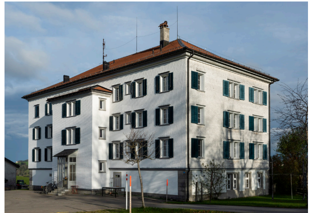
Abb. 36 Walmdach, eh. Waisenhaus, Holderschwendi 16, Speicher
