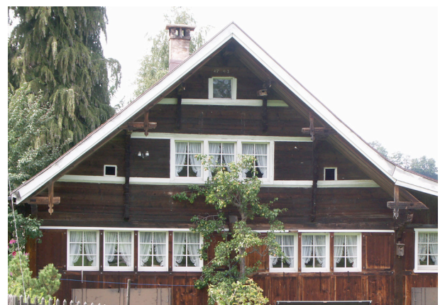
Abb. 40 Vordach mit Flugsparrendreieck, Hartmannsrüti 227, Grub
