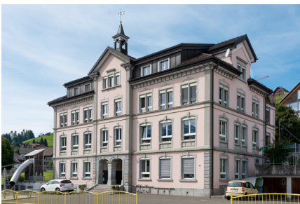
Abb. 24 Schulhaus, Dorfstrasse 58, Gonten
