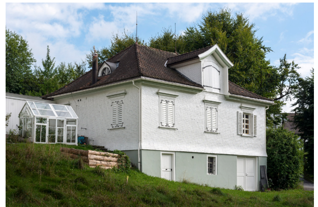
Abb. 39 Remise, Dorf 6, Teufen
