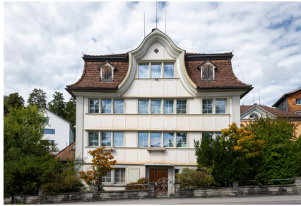
Abb. 31 Mansarddach, Langgasse 10, Gais Martin Benz, Teufen 2023
