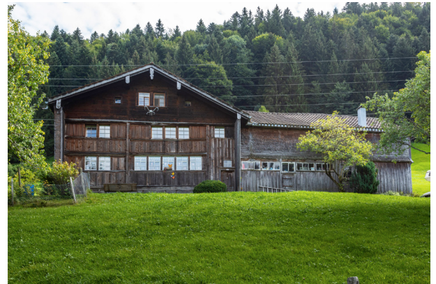
Abb. 36 Flach geneigtes Tätschdach mit Kreuzfirst, Hinterfür 980, Urnäsch
