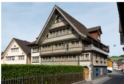
Abb. 19 Bürgerhaus, Engelgasse 7, Concordia, Appenzell
