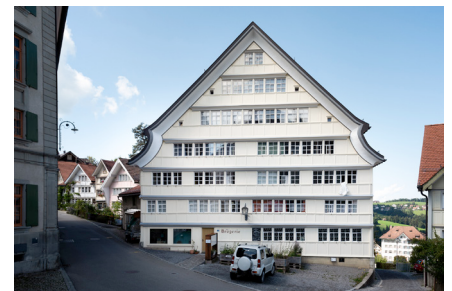
Abb. 28 Ehemaliges Gasthaus / alte Dro- gerie, Hinterdorf 25, Trogen
