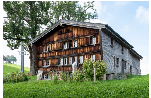
Abb. 14 Tätschdachhaus, Birtweg 1, Speicher
