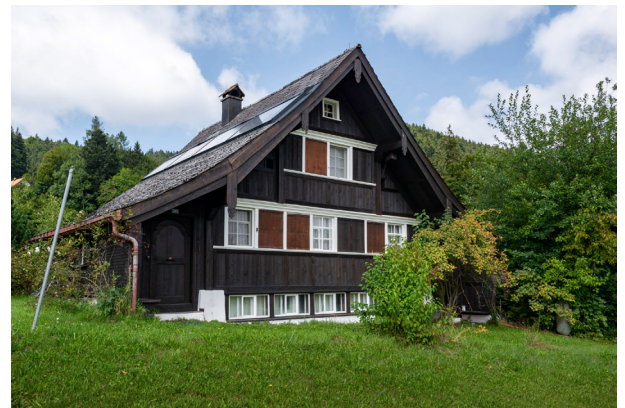
Abb. 37 Steildach genagelt, Wellenrüti 586, Teufen
