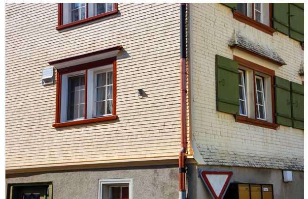
Abb. 64 Sockelsims in Blech, Hauptstrasse 28, Speicher
