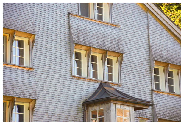
Abb. 59 Seitenbretter, Ohrenklappen, Spiessenrüti 514, Teufen
