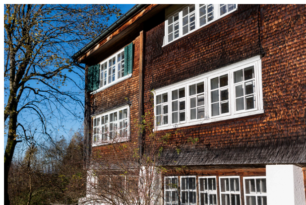
Abb. 67 Strickvorstoss mit Bretterverkleidung, Langenhus 1, Trogen
