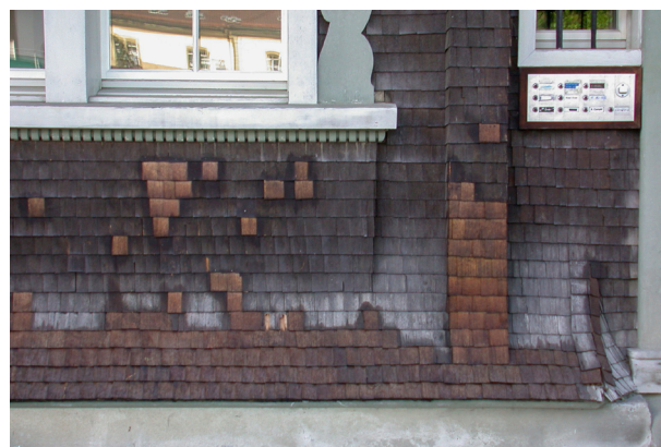
Abb. 71 Zugladen und Strickvorstoss geschindelt, Oberdorfstrasse 93, Herisau
