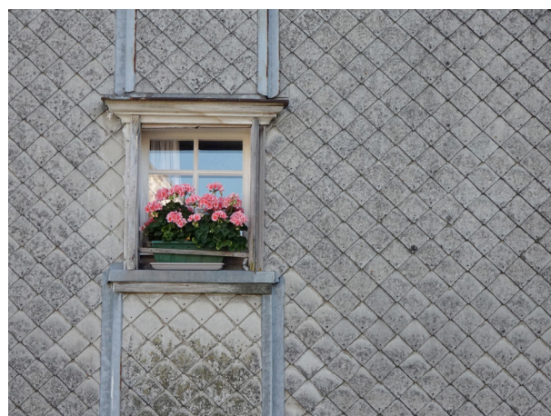
Abb. 73 Faserzement-Schiefer Rauten, Hechtgasse 10, Wolfhalden
