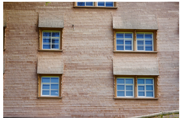
Abb. 70 Fallladen hinter Abwurf, Hinterhof 2240, Herisau
