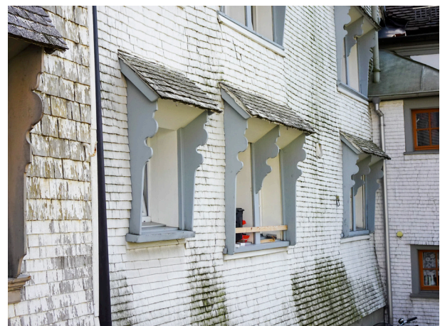
Abb. 58 Seitenbretter, Ohrenklappen, Dorf 1, Rehetobel
