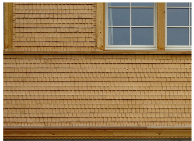
Abb. 39 Grosse Überdeckung erste Reihe Schlaufschild, Rotschwendi 194, Schwellbrunn
