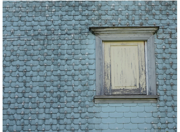
Abb. 74 Faserzement-Schiefer mit Stutzeck, Luchten 92, Wolfhalden
