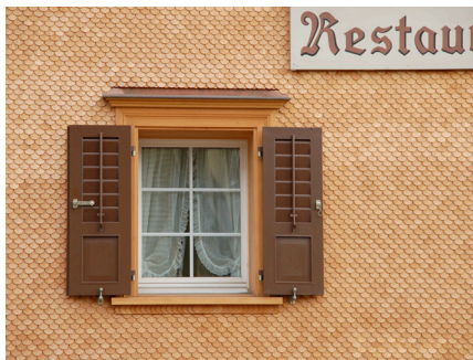
Abb. 30 Rundschindelschirm, Fensterdächlein und Blechabdeckung, Dorf 16, Hundwil
