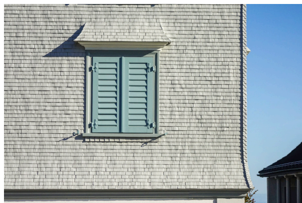
Abb. 66 Abwurf über einfachem Sockelprofil, Dorf 2, Wolfhalden
