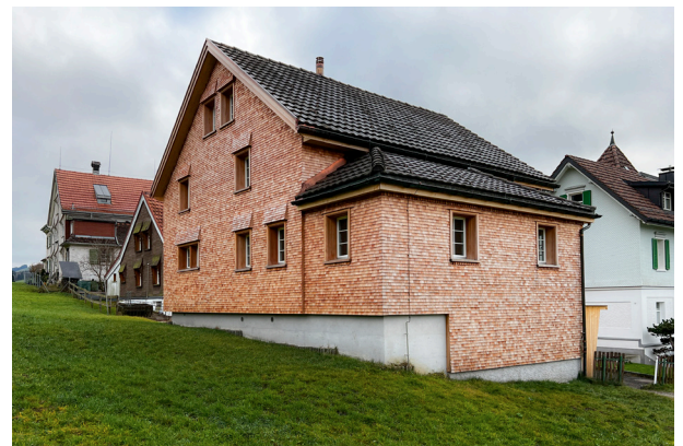
Abb. 63 Sockelübergang ohne Abwurf und Sims, Speicherstrasse 25c, Teufen
