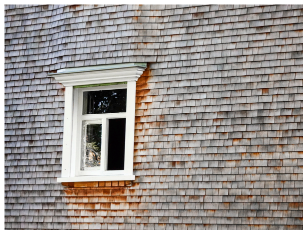
Abb. 14 Rechteckprofile mit Viertelstab und Hohlkehle, Hechtgasse 22, Wolfhalden
