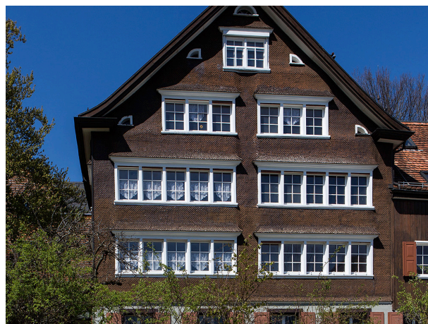
Abb. 12 Schindelfassade mit Abwürfen und Simsens, Lachen 749, Walzenhausen
