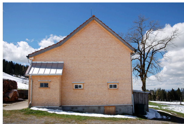
Abb. 3 Ostfassade Stall, Neppenegg 21, Speicher
