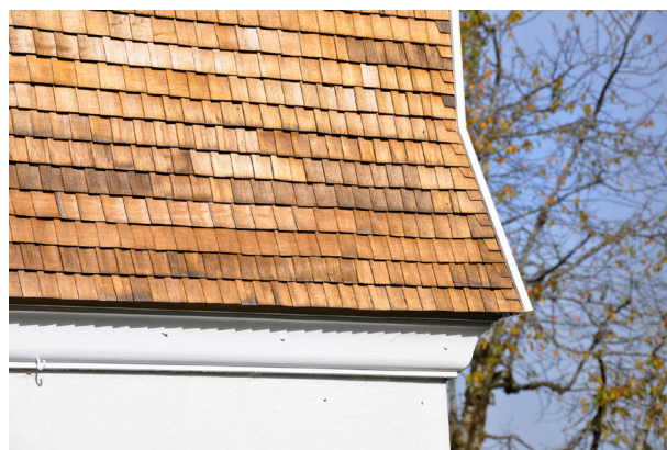
Abb. 65 Abwurf über Karniesprofil, Oberdorfstrasse 95, Herisau
