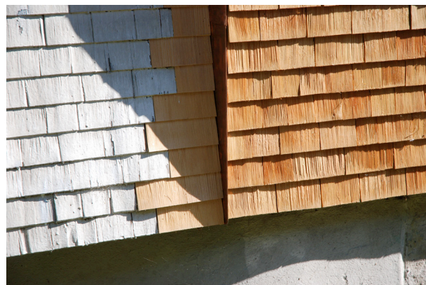
Abb. 24 Reparaturstelle Glattschirm, Unterrain 22, Teufen
