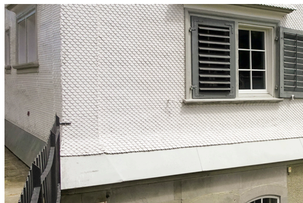
Abb. 61 Abwurf in Blech, Dorfstrasse 10, Bühler
