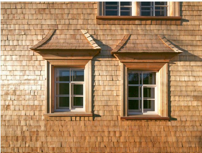
Abb. 54 Fensterabwurf gewalmt mit geschindeltem Grat, Egglis- strasse 9, Teufen Bildarchiv Denkmalpflege Appenzell Ausserrhoden
