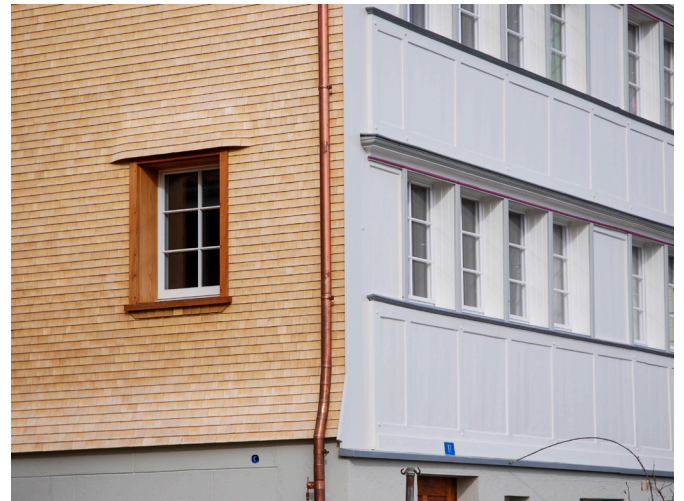
Abb. 53 Fensterabwurf geschweift, Kohlhalden 11, Speicher Bildarchiv Denkmalpflege Appenzell Ausserrhoden
