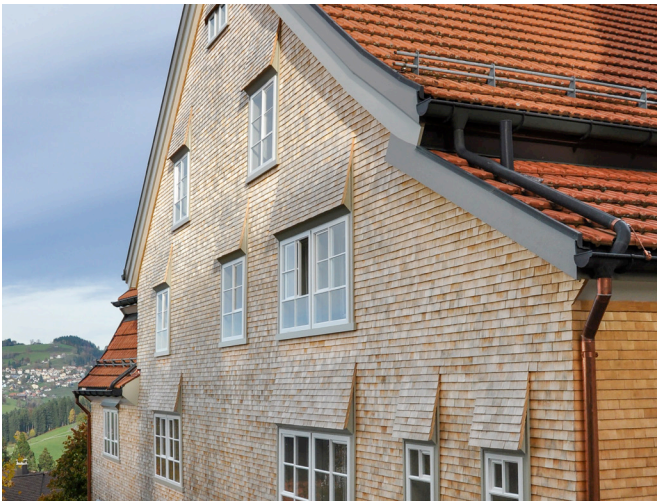
Abb. 52 Einfacher Fensterabwurf, Bergweg 5, Trogen Bildarchiv Denkmalpflege Appenzell Ausserrhoden
