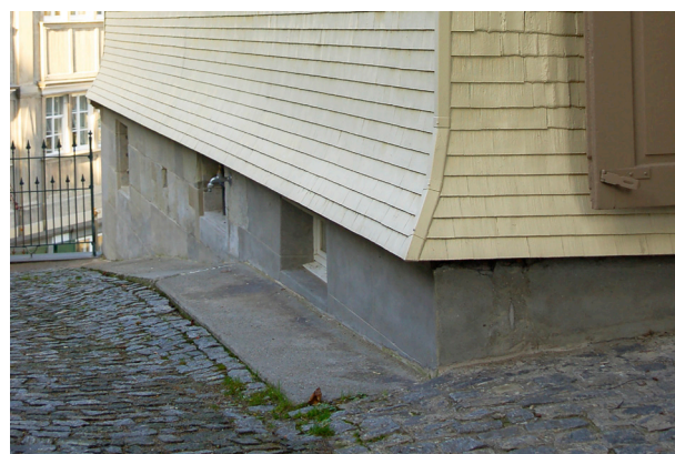
Abb. 60 Sockeldetail mit Abwurf, Ecke mit Blechprofil, Landsgemeindeplatz 10, Trogen
