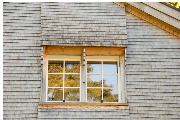
Abb. 45 Gebinde Dachrand und Fenstersims, Glattschirm, Spiessenrüti 498, Teufen
