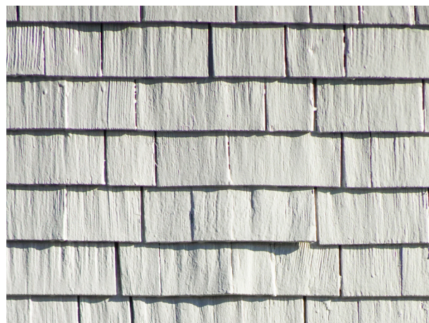
Abb. 40 Glattschirm aus unterschiedlich breiten Fichtenschindeln, mit Ölfarbe gestrichen
