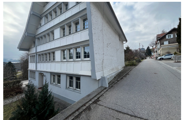
Abb. 69 Strickvorstoss geschweift geschindelt, Sonderstrasse 1, Rehetobel
