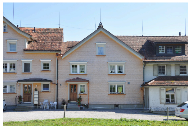
Abb. 7 Geschindelte Rückfassaden, Zwislenstrasse 1, Gais
