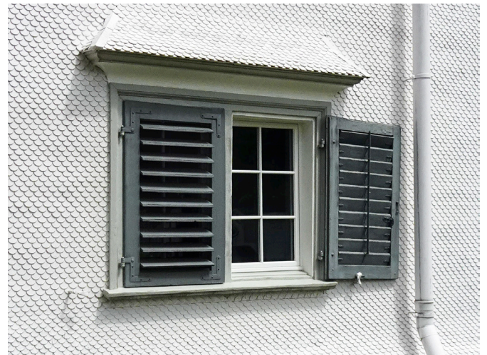
Abb. 55 Fensterabwurf über Hohlkehle, gewalmt mit Grat und Blechgrat, Dorfstrasse 10, Bühler Bildarchiv Denkmalpflege Appenzell Ausserrhoden
