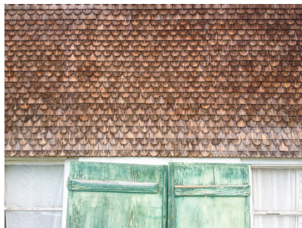
Abb. 20 Schindelschirm mit Glatt- und Rundschindeln, Leuchten, Walzenhausen
