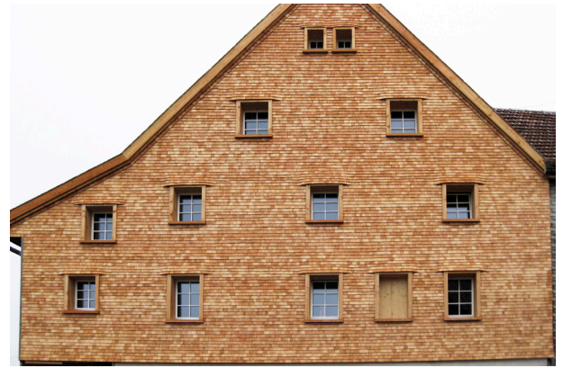
Abb. 62 Sockelübergang ohne Abwurf und Sims, Nord 5, Rehetobel
