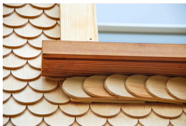
Abb. 46 Gebinde Fenstersims, Rundschindeln, Tobel 103, Lutzenberg
