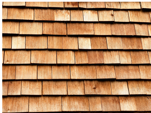
Abb. 10 Fichtenschindel gespalten
