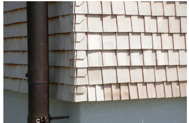
Abb. 48 Ecke Schlaufschild mit gestutzten Eckschindeln, Spiessenrüti 498, Teufen
