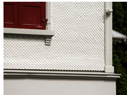
Abb. 31 Rundschindeln, Sockelsims mit Blechabdeckung, Kasernenstrasse 38, Herisau
