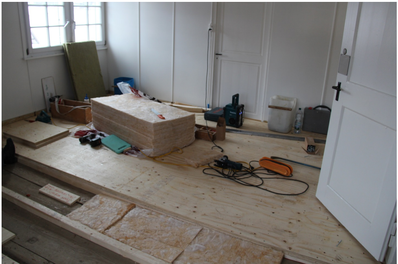
Eine Hohlraumdämmung für die Amplitudendämpfung bringt ca. 10db Luftschalldämmung
