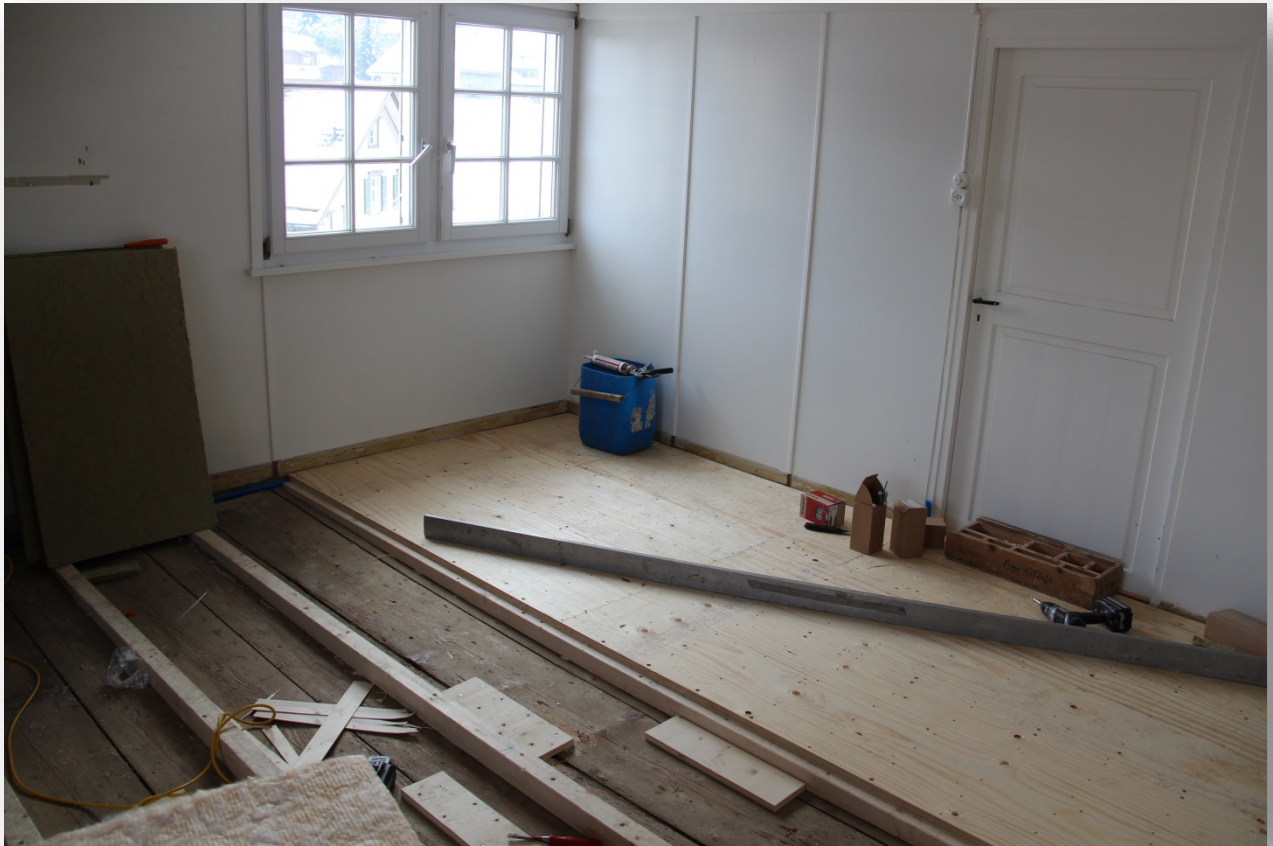
Die neue Bodenplatte wird ohne Querstöße auf die Schiftung geleimt und geschraubt
