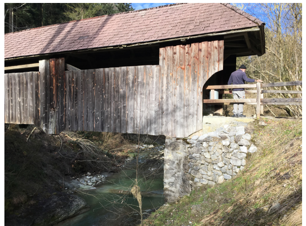
Abb. 24 Widerlager Oberach Brücke zwischen Speicher und Rehetobel
