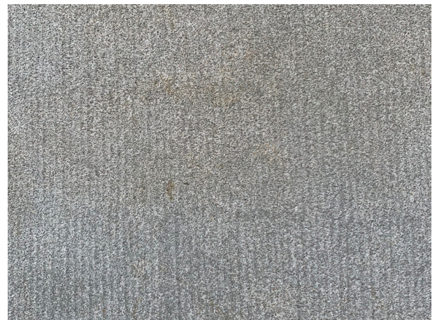
Abb. 33 Oberfläche scharriert
