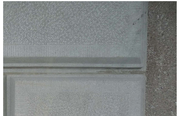
Abb. 32 Quaderstein gestockt mit scharrierten Kanten
