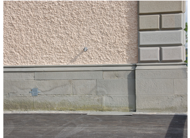
Abb. 29 Sockel und Eckpfeiler, Zeughaus Teufen
