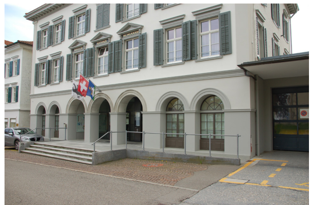
Abb. 39 Treppenanlage, Rampe, Geländer Rathaus, Kirchplatz 6, Heiden
