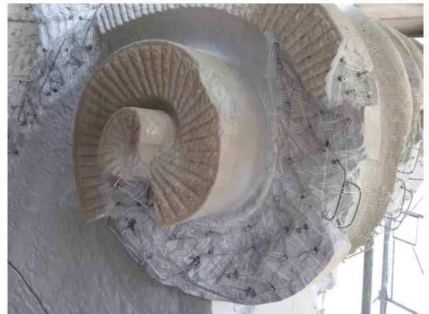
Abb. 25 Armierung für Reprofilierung
