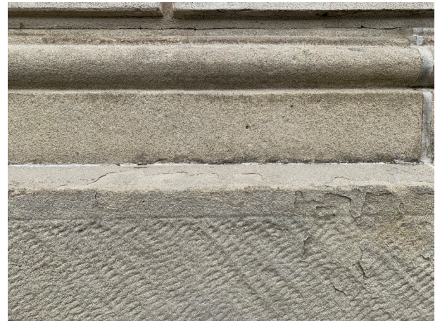
Abb. 28 Schalenbildung nach Hydrophobierung
