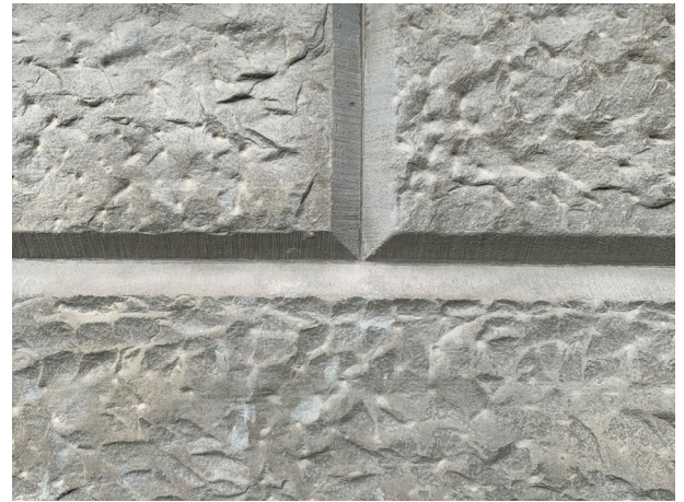
Abb. 34 Quader bossiert mit scharrierter Fase
