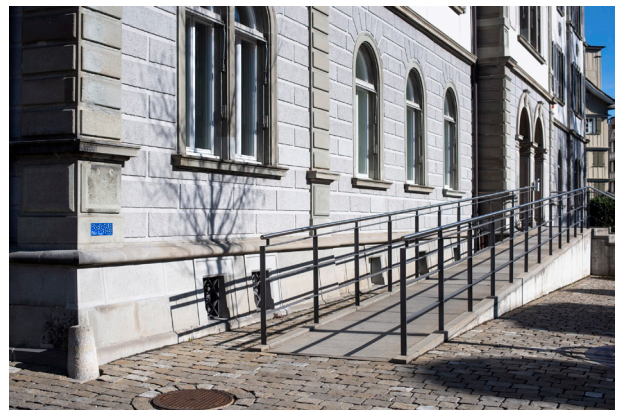
Abb. 38 Treppenanlage, Rampe, Geländer, Gemeindehaus, Poststrasse 6, Herisau
