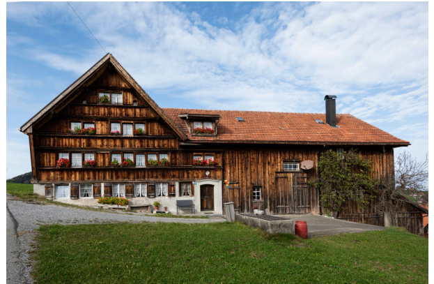
Abb. 2 Dunkle Holzfassade über Sandsteinsockelgeschoss, Bruggmoos 32, Speicher
