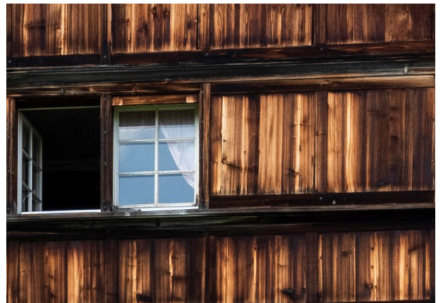
Abb. 34 Strickbau mit Täferfassade
