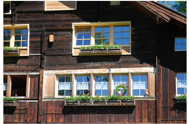
Abb. 29 neues Fensterfutter mit Abtreppung, Wienacht Tobel
