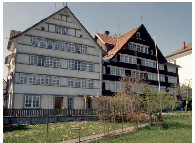
Abb. 3 Dorfhaus mit hell gestrichener und dunkel verwitterter Fassade, Dorf 6/8, Speicher
