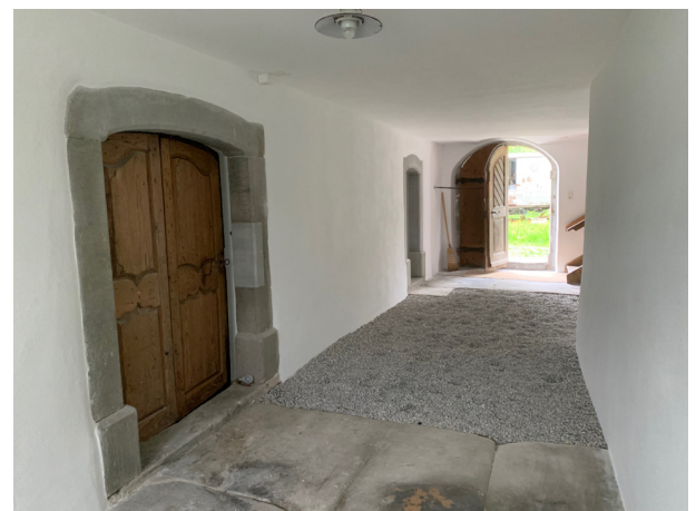
Abb. 6 Kellerraum mit Sandsteinplatten und Kiesboden
