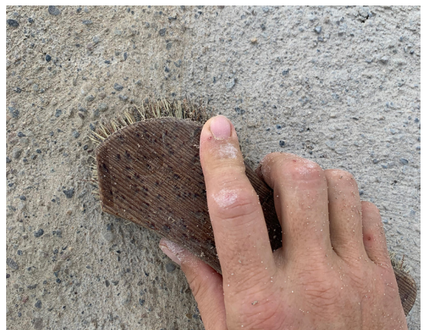
Abb. 19 Abbürsten Sinterschicht
