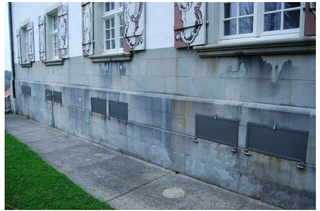
Abb. 7 Kellerraum mit Sandsteinplatten und Kiesboden Bildarchiv Denkmalpflege Appenzell Ausserrhoden
