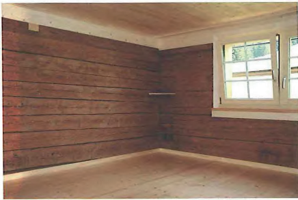
Innenansicht 1 nach der Sanierung: Strickwand sichtbar, Aussendämmung in Hohlraum des ehemaligen Zuglades
